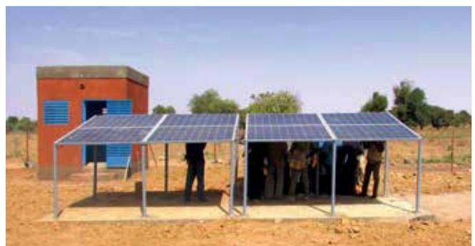
Die beiden Trinkwasserbrunnen werden über Solarmodule betrieben.
