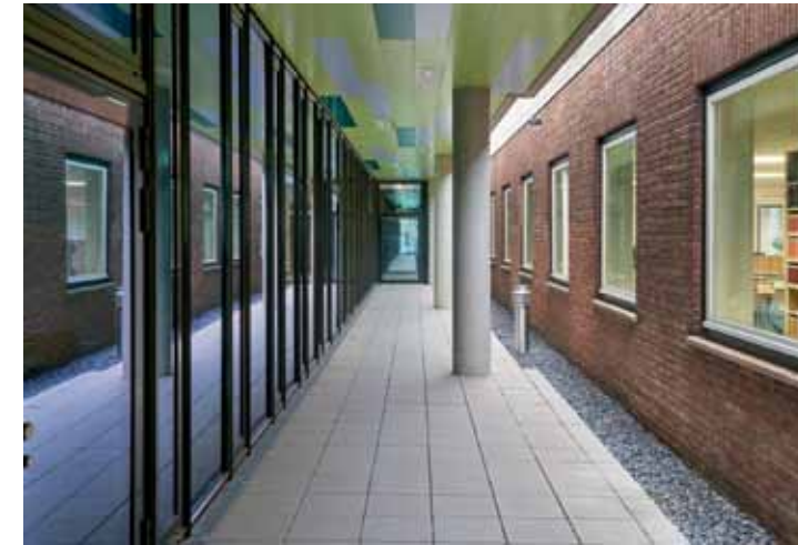
Fuge zwischen Bestand und Neubau.
