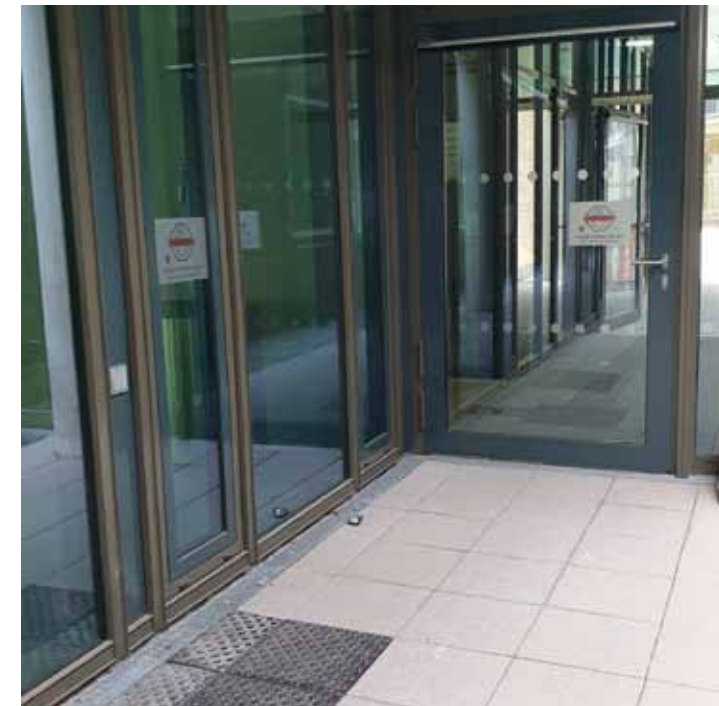
Taster zur Türbedienung mit Bedienungsschildern und Aufmerksamkeitsfeldern am Boden.
