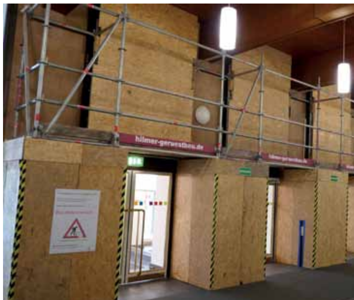
Einhausung im Bereich des Haupteingangs mit der Galerie.
