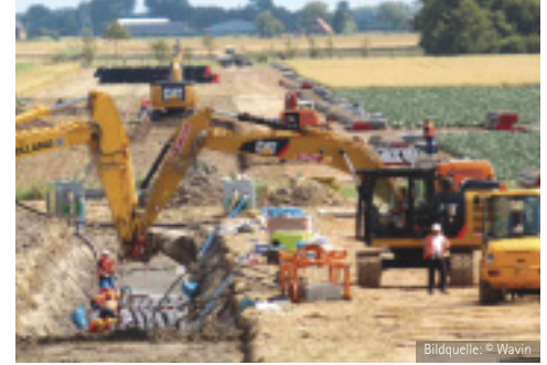
Schutzrohre für unterirdische Hochspannungskabel („Erdverkabelung“)
