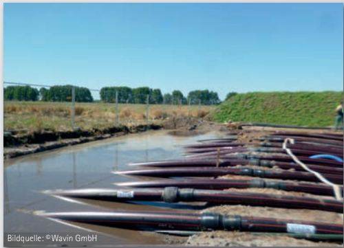
PE-RT Kabelschutzrohre, Projekt Fürstenwalde
