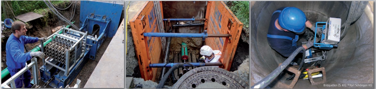
Statisches Berstlining, Verfahrensvariante Press-Bersten DN 200, Schachtbohrlafette Grundobore 200S (Tracto-Technik GmbH)
