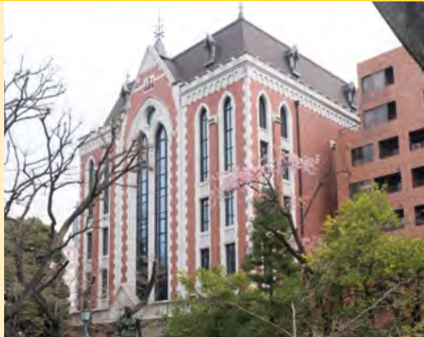
› Hauptgebäude der Keio Universität
