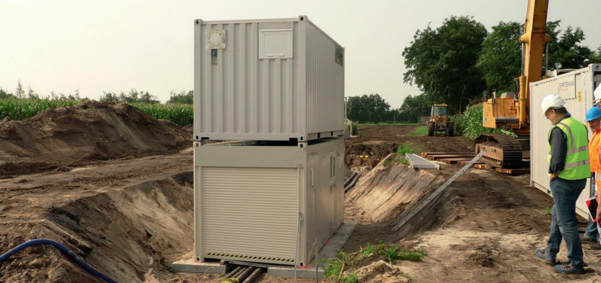
Abbildung 1: Container zur Montage der Kabelmuffen (Quelle: TenneT TSO GmbH)
