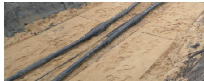
Abbildung 2: Fertig installierte Muffe zur Verbindung zweier Kabelabschnitte (Quelle: TenneT TSO GmbH)
