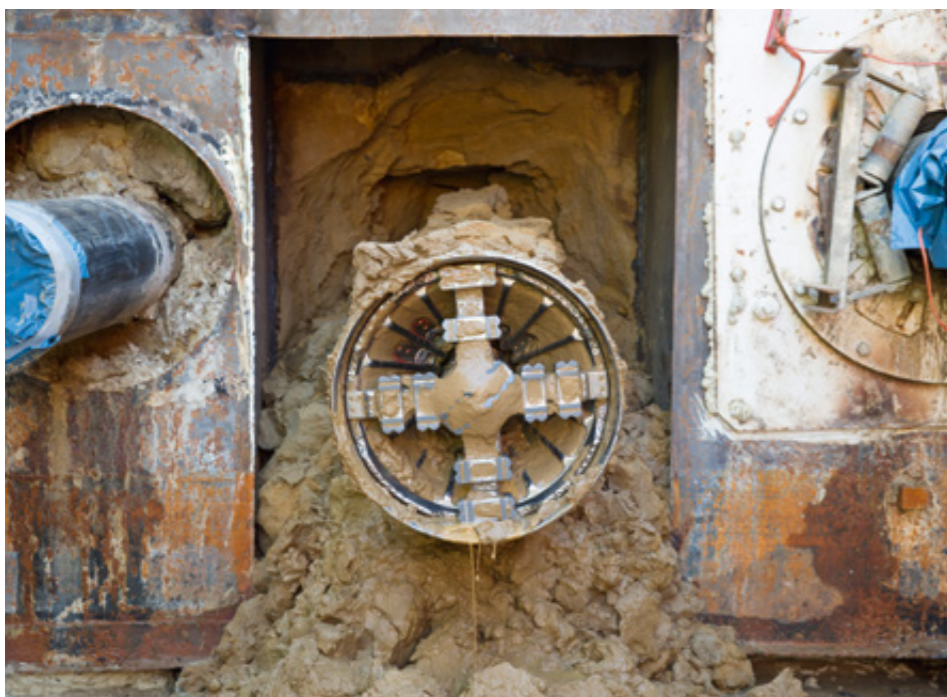
Abbildung 1: Tunneldurchbruch der Bohrung auf der Pilotstrecke
