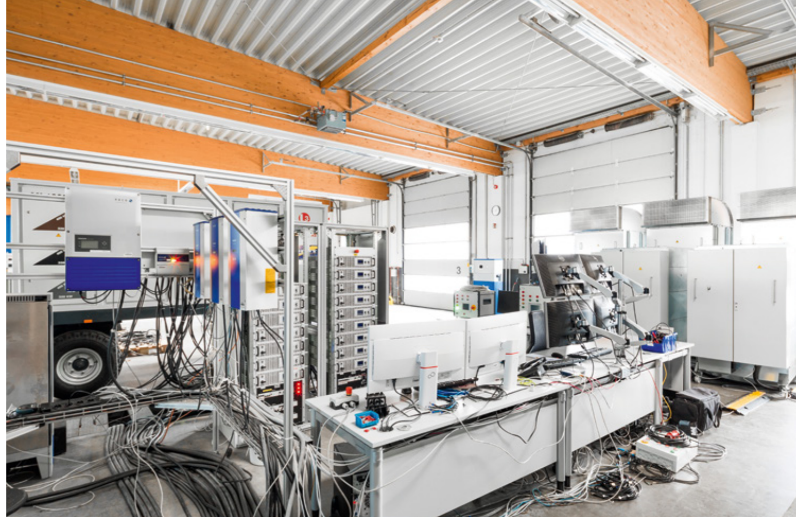
Abbildung 1: Zentrum für Netzintegration und Speichertechnologien
