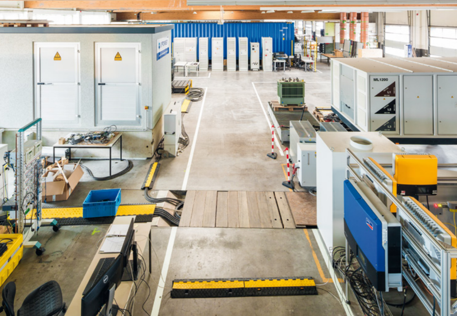
Übersicht der Komponenten des Testzentrums für Netzintegration und Speichertechnologien
