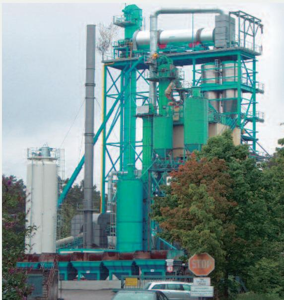
*Paralleltrommel – hoch gesetzt und mit anschließenden Asphaltgranulat-Heißsilos (silbern), die die Zugabe von erwärmtem Asphaltgranulat kurzfristig und auch bei der Produktion von Kleinmengen ermöglichen.*
