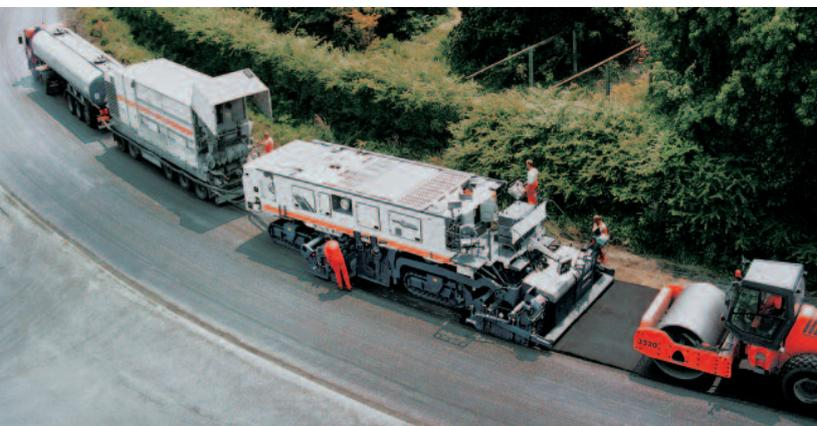
Kaltrecycler bei der Herstellung einer bitumen-dominanten KRC-Schicht
