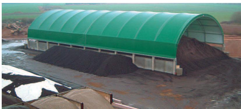
*Die überdachte Lagerung von trockenem Asphaltgranulat hilft, den Primärenergiebedarf in der Asphaltmischanlage zu senken*
