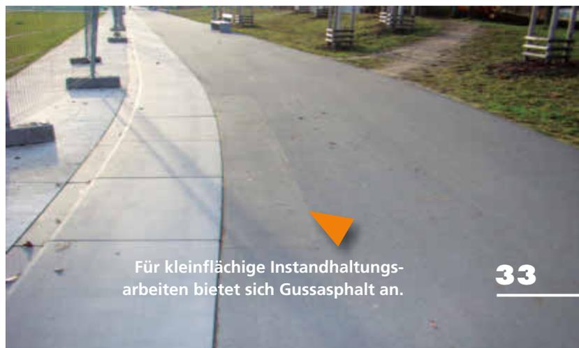
Für kleinflächige Instandhaltungsarbeiten bietet sich Gussasphalt an.
