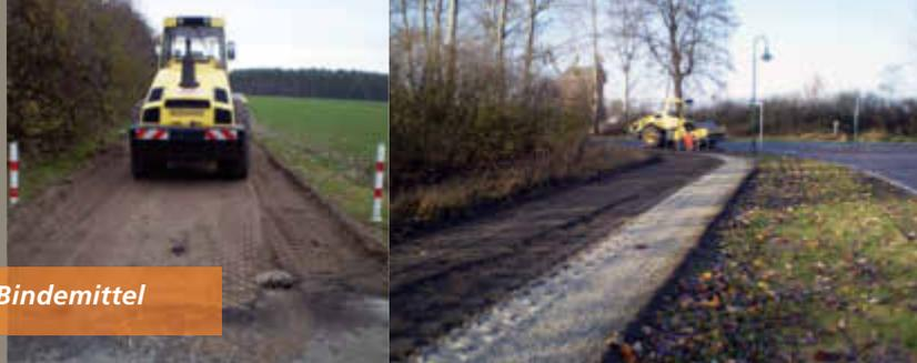
Entscheidend ist: Auf der obersten Schicht ohne Bindemittel unterhalb der Asphalt(schicht(en)) muss ein Verformungsmodul  $E_{v2} \geq 80 \text{ MPa}$  (nach ZTV SoB-StB 04/07) oder ein **dynamischer Verformungsmodul  $E_{vd} \geq 40 \text{ MPa}$**  (Empfehlung der DAV-Autoren) nachgewiesen werden.
