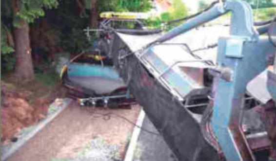
Beschickung des Straßenfertigers mittels eines „Beschickers“ (Übergabefertiger)
