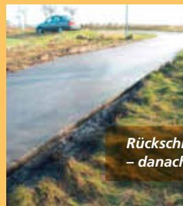
*Rückschnitt eines geschädigten Bereiches – danach Versiegelung nicht vergessen!*
