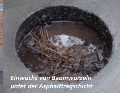
Einwuchs von Baumwurzeln unter der Asphalttragschicht
