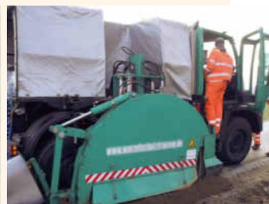
Wurzelschutzfräse zum Einbau einer Wurzelschutzfolie
