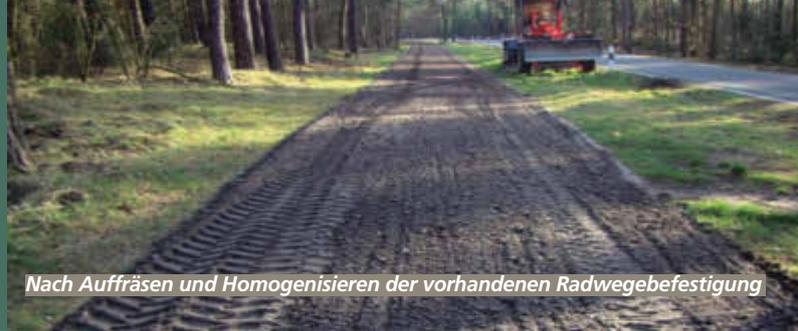
Nach Auffräsen und Homogenisieren der vorhandenen Radwegbefestigung
