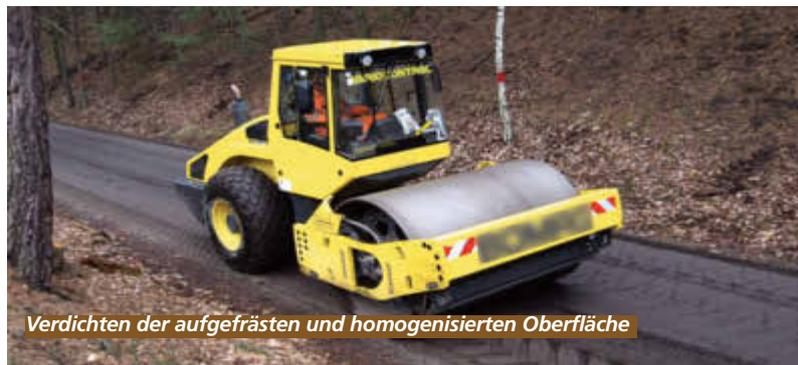
Verdichten der aufgefärsen und homogenisierten Oberfläche
