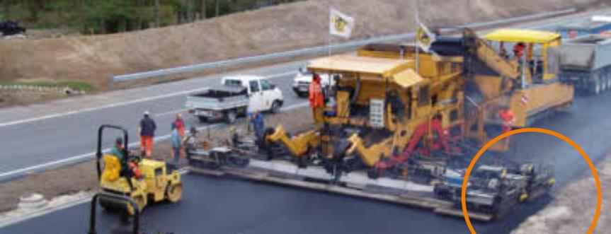
Spezialfertiger mit zwei Einbaubohlen
