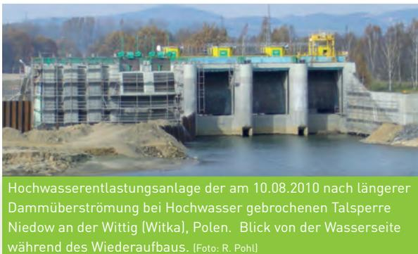
Hochwasserentlastungsanlage der am 10.08.2010 nach längerer Dammüberströmung bei Hochwasser gebrochenen Talsperre Niedow an der Wittig (Witka), Polen. Blick von der Wasserseite während des Wiederaufbaus. (Foto: R. Pohl)
