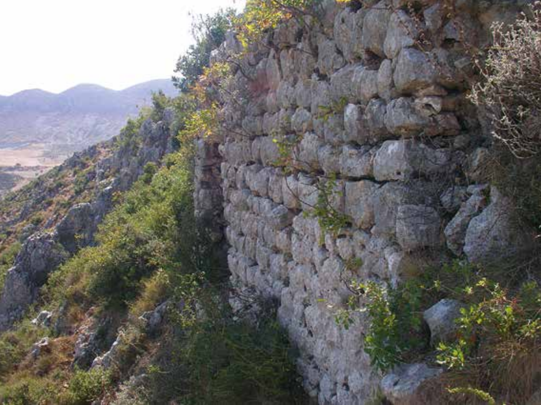
Die Mauern, die Staurin- und Silpiosbefestigung miteinander verbinden, bestehen aus Mörtelmauerwerk mit einer Steinverschalung.
