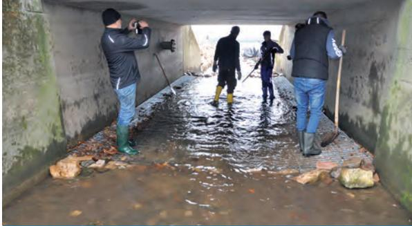
Nach der Installation der Metallgitter im November 2017 unter dem Brückenbauwerk wurden im Rahmen eines Projekttagges der HS RheinMain aus Wiesbaden die Zwischenräume mit ortstypischen Sedimenten befüllt. Fotos: Thomas Paulus
