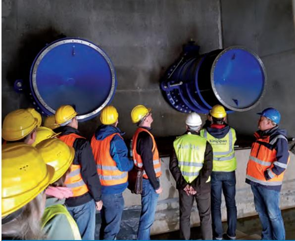
Besichtigung der Toskammer und des Kegelstrahlschiebers des Hochwasserrückhaltebeckens Niederpöbel (Foto: Ulf Möricke)
