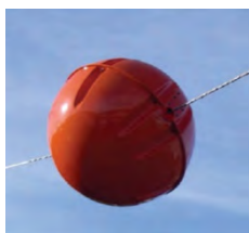
Abb. 2: Fest installierte Markierungsbälle, sogenannte 'aviation balls', sind oftmals farbige Bälle, welche fest am Erdseil angebracht werden. Die derzeit verfügbaren Durchmesser reichen von 23 cm bis 137 cm. Foto: APLIC (2012).
