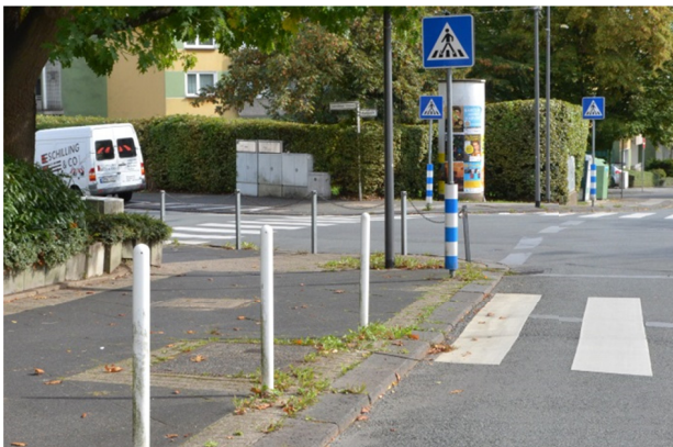
Aufstellen von Pollern zur Verhinderung des unerlaubten Parkens
