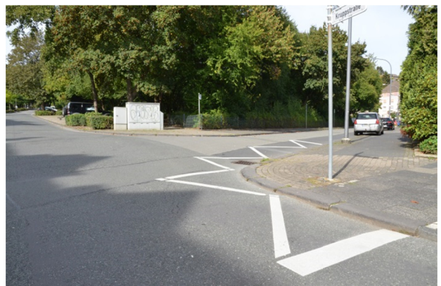
Grenzmarkierung zur Verhinderung des Parkens im Einmündungsbereich
