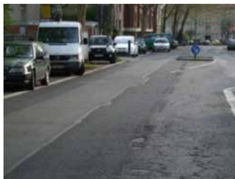
Abb. 6: Straßenschäden mit Tiefenwirkung – Erneuerung wird grundhaft wahrscheinlich und teuer sein
