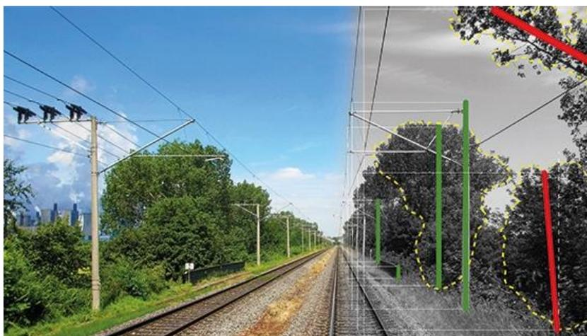
Abbildung 14: Beispieldarstellung von Veränderungen entlang einer Bahntrasse im Projekt „Zustandsüberwachung des Gleisumfeldes“ (ZuG)
