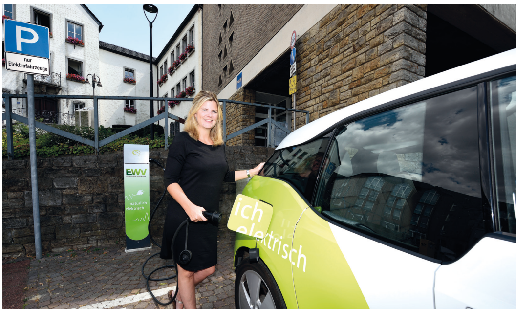
Die EWV-Ladesäule vor dem Rathaus der Stadt Übach-Palenberg.
