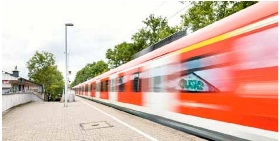
Der vorhandene S-Bahnsteig in Bergisch Gladbach-Duckterath wird auf 96 Zentimeter angehoben, um einen höhengleichen Einstieg in die Bahnen zu ermöglichen.
