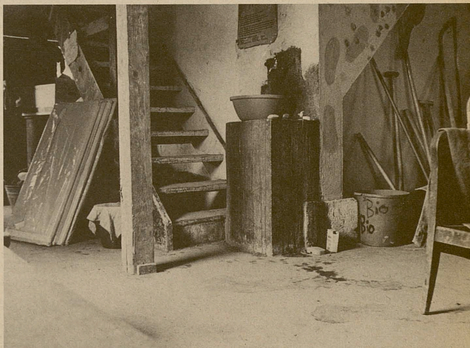
Glotzt unpassend aus der Wand: der Wasserhahn
