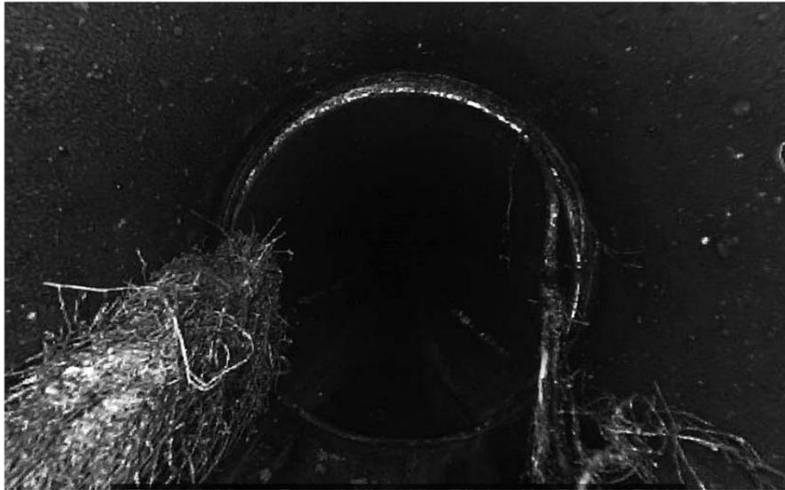
Wurzelnwuchs in den Abwasserleitungen
