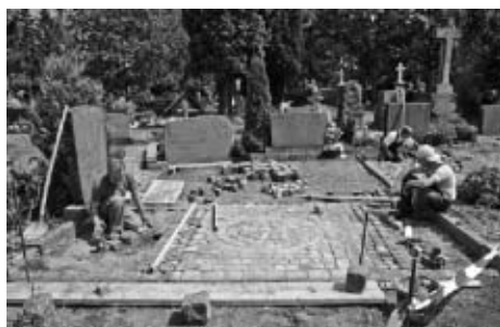
Kennzeichnung des Fundamentverlaufs durch Pflasterung
