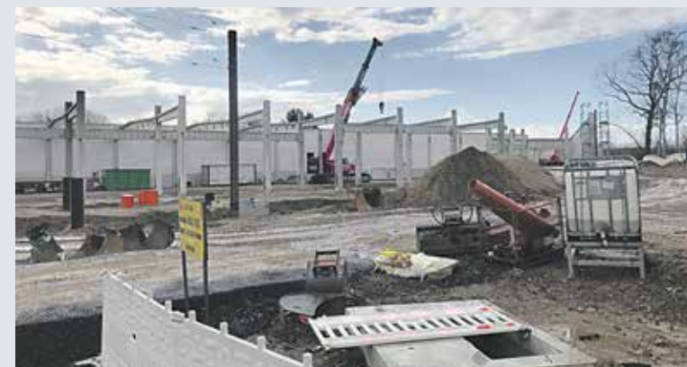
Die Baumaßnahmen gehen weiter planmäßig voran
