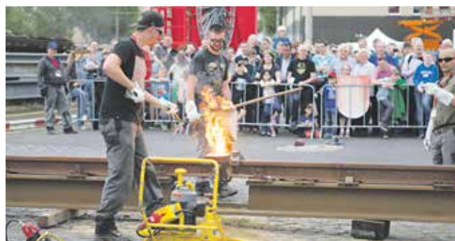
Ein Höhepunkt: das spektakuläre Schienenschweißen
