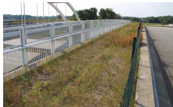
Abb. 3: Bsp. einer Grünstreifenbrücke Foto: H.Reck Fig. 3: Example of a bridge with a vegetated strip
