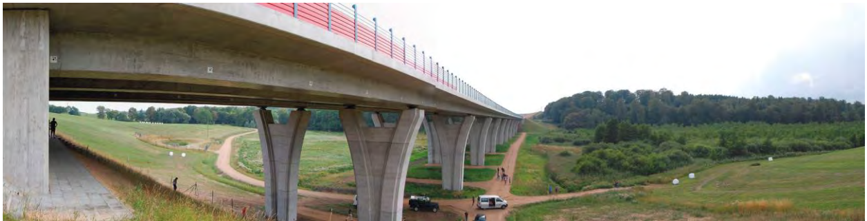
Abb. 10: Die unzureichende Gestaltung von Talbrücken ist kein Einzelfall Foto: R. Sommer & H. Reck Trotz der Zerschneidung von Waldlebensräumen fehlt u.a. der Gehölzverbund und der Bau- bzw. Unterhaltungsweg wirkt als Barriere für Kleintiere.
