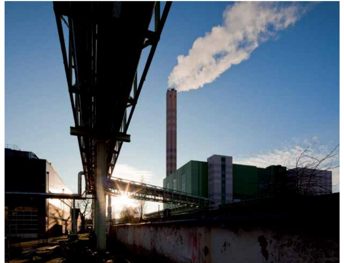
Kein Rauch, sondern Dampf: Je nach Außentemperatur wird die Wasserdampffahne über dem Schornstein der MVA sichtbar.
