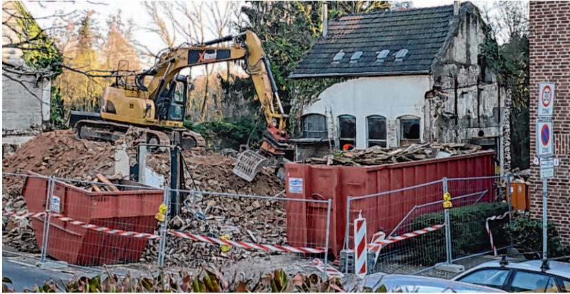
Erste Bauarbeiten zur Neugestaltung der Innenstadt stehen an: Abrissarbeiten finden in der Eyselshovener Straße statt. Foto: Projekt-Büro Herzogenrath-Mitte
