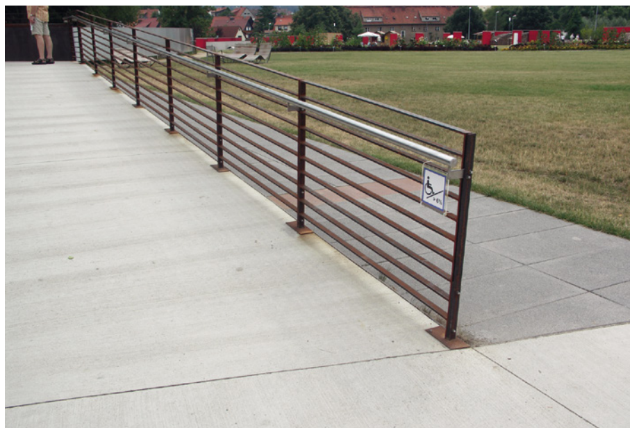
Abbildung 34: Hindernisfreie Erschließung durch großzügige Rampen
