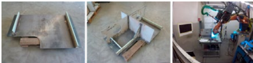
Abbildung 13: Fertigungsschritte der Bauteildemonstratoren (Quelle: MEYER WERFT)
