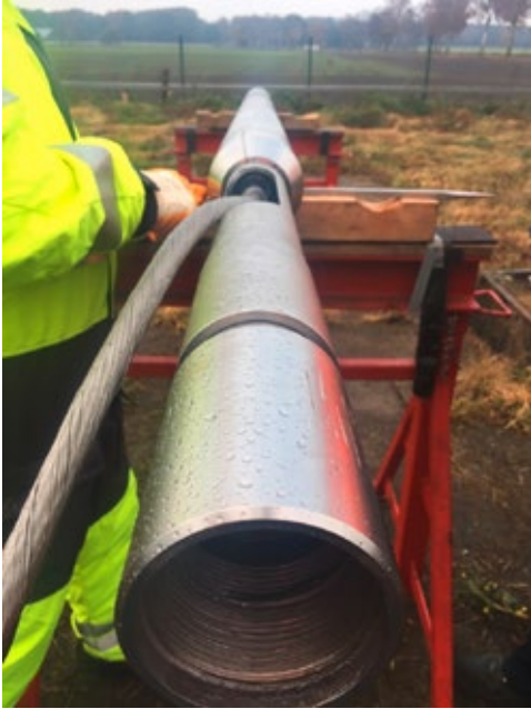
Abb. 10: Vorbereitung der MDA-Installation
