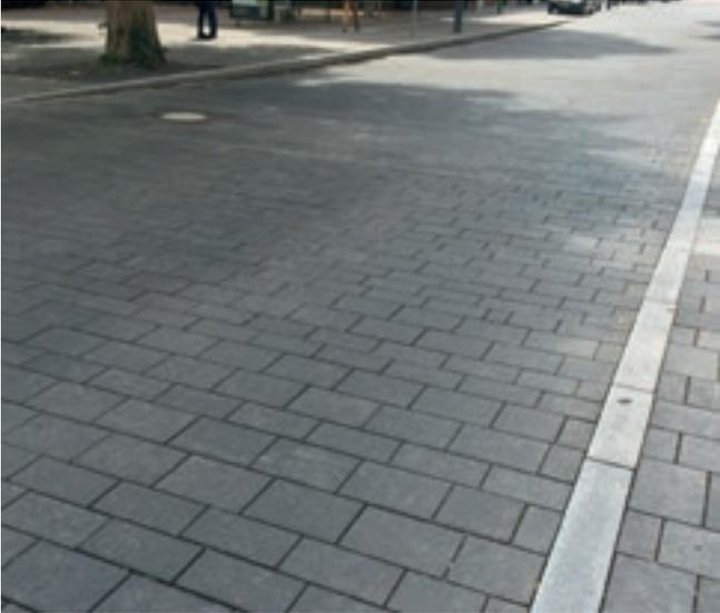
53 Abgesenkte Straße zum temporären Rückhalt von Abflussspitzen
