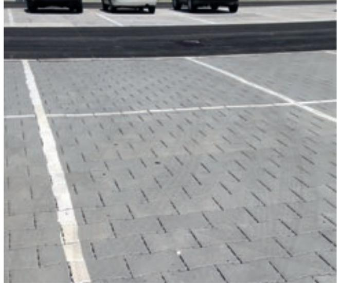
26 Versickerungsfähiges Pflaster
