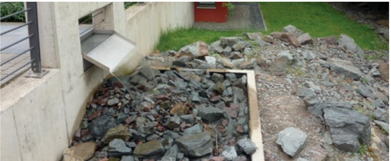
33 Ableitung von Gehwegabflüssen in eine Versickerungsanlage
