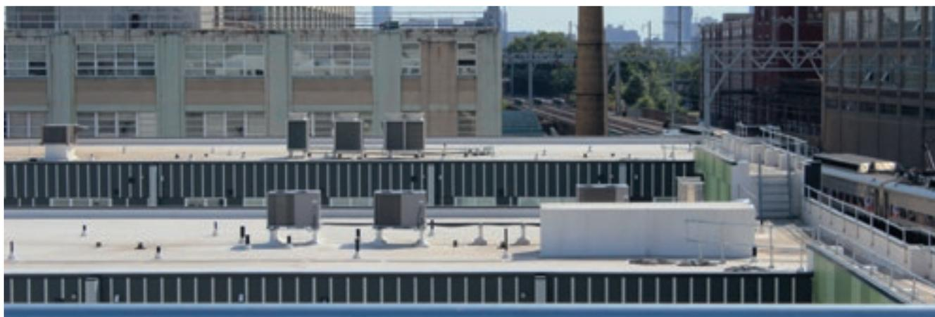
46 Dach mit erhöhter Regenauffang- und Rückhaltekapazität
