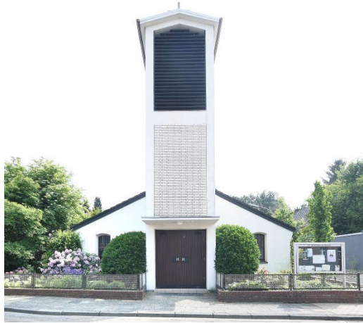
Bild 35: Im Jahre 1963 wurde der alte Holzturm der Kirche durch einen hohen Kirchturm in Massivbauweise ersetzt.
