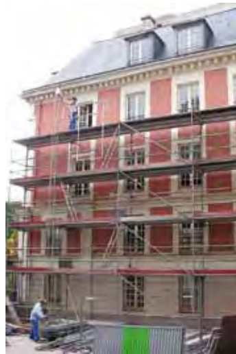
Gebäuderenovierung DHI Paris
