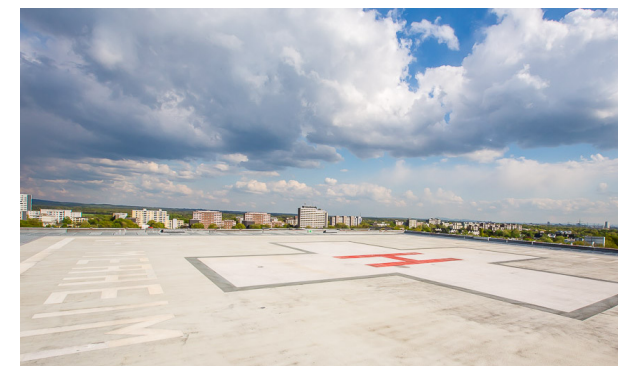
Beginn des Rundgangs durch die Klinik auf dem Hubschrauberlandeplatz
