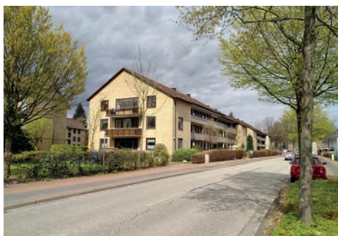
Die Bestandsgebäude an der Rudolf-Breitscheid-Straße
