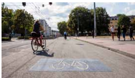
Piktogramme auf der Straße verdeutlichen es: Dieser Teilabschnitt der Zülpicher Straße ist jetzt eine reine Fahrradstraße. [Foto: verenaFOTOGRAFIERT]
