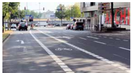
Eine ausschließlich dem Radverkehr vorbehaltene neue Linksabbiegerspur südlich des Maritim-Hotels erleichtert diesem die Fahrt in die Altstadt und auf die Nordseite der Deutzer Brücke.
