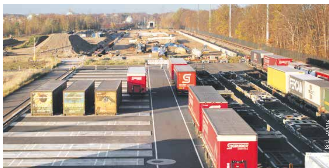
Im Hintergrund wird schon gebaut: Hier werden die Gleise auf 700 Meter verlängert.
