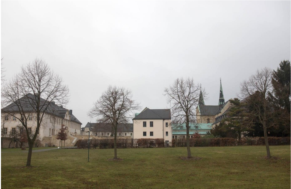
Abbildung 84: Klosteranlage Huysburg (Foto: Nicole Reppin)
