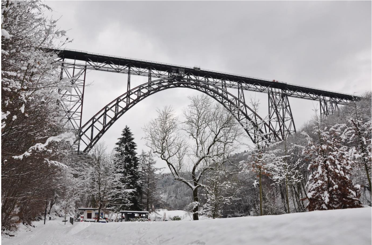
Abbildung 75: Müngstener Brücke über das Tal der Wupper (Foto: Deborah Hoheisel)
