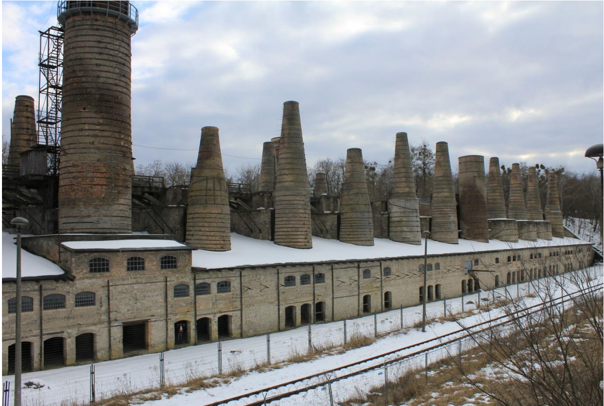
Abbildung 101: Industrieästhetik: Ehemals zur Branntkalkherstellung genutzte Schachtofenanlage im Museumspark Rüdersdorf (Foto: Werner Konold)
