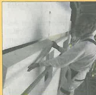
Ein lückenlos gedämmter Fassadenaufbau lässt sich mit neuen Hocheffizienz-Brandschutzriegeln realisieren.
