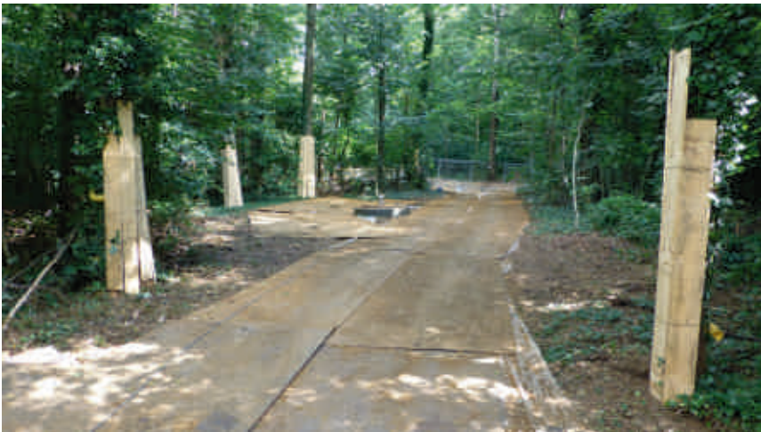
Bild 5.5: Auslegung von Stahlplatten und Baumschutz im Arbeitsbereich
