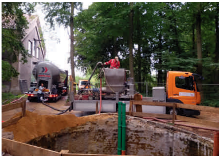
Bild 5.8: Verfüllung eines Heberrohrganges mit Dämmen
