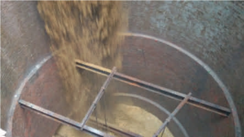
Bild 5.6: Teilverfüllung des Brunnenschachtes mit Kies
