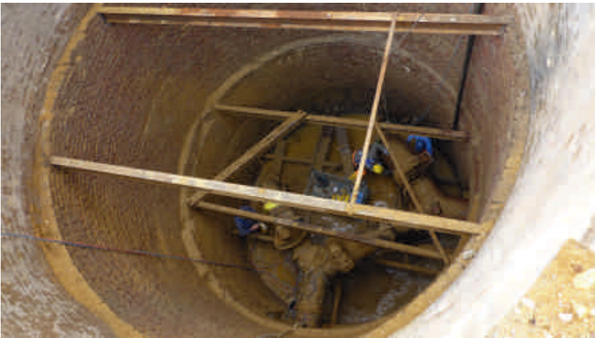
Bild 5.7: Demontage der Rohrleitungen und Armaturen im Brunnenschacht
