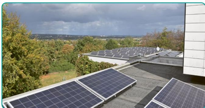
Fast alle Dächer der Jugendakademie werden nunmehr zur Produktion von Sonnenenergie genutzt. Im Bild: Die seit kurzem erweiterte Photovoltaikanlage, die mit insgesamt knapp 20 kWp fast 2/3 des Strombedarfs der Jugendakademie deckt. Während der gewonnene Strom aus der 2003 installierten Photovoltaikanlage zu einem Festpreis eingespeist wird, kann der Strom, der aus den neuen Solarpanelen gewonnen wird, direkt von der Jugendakademie genutzt werden.
