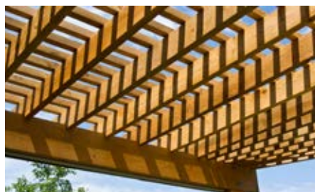
Die Pergola gibt es in der klassischen Form bestehend aus Holzpfählen, Traghölzern, Querbalken und Dachsparren.
