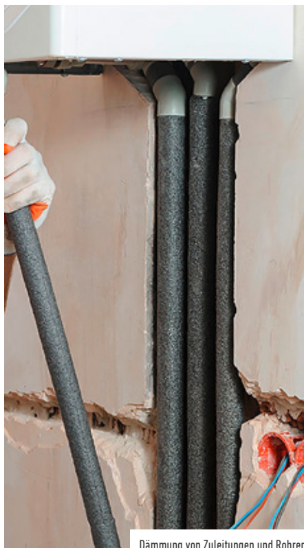
Dämmung von Zuleitungen und Rohren
