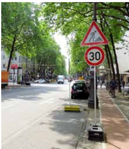
Start der Umbaumaßnahmen für die Pilotstrecke auf dem Hohenstaufenring
