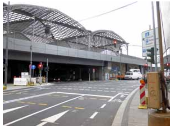
Neue und breitere Markierungen sollen die Situation für den Radverkehr in der Domumgebung verbessern.
