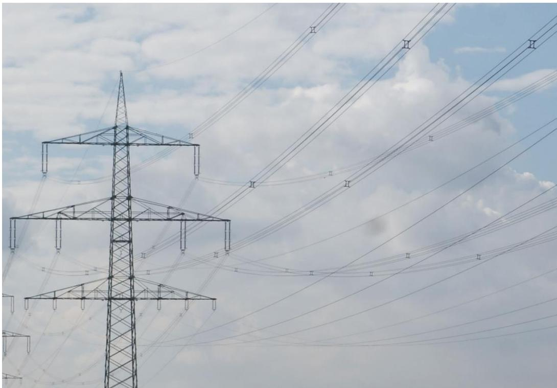
Abb. 16: Kombination aus 110 kV-Einzelleitung und 380 kV-Leitung mit 4er-Bündel (K. FOLLNER ).
