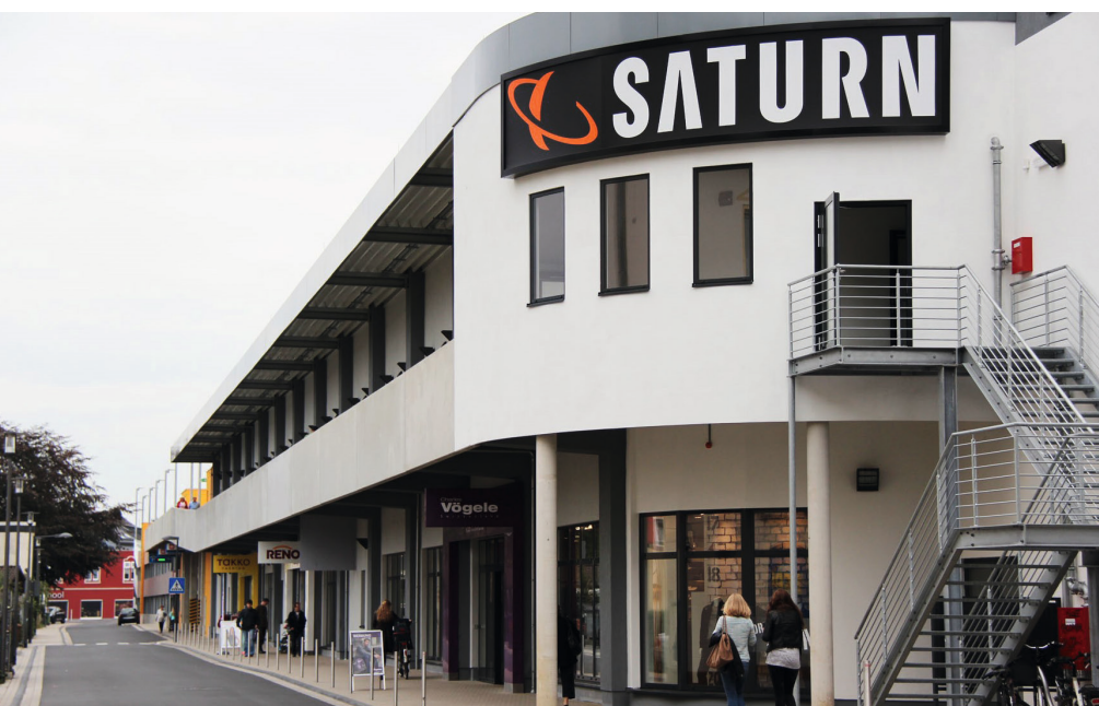
Einkaufszentrum an der Ladestraße in Hennef
