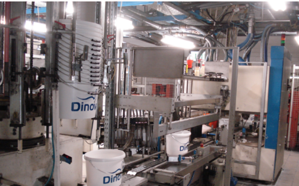
LED-Beleuchtung in der Farbenabfüllung
