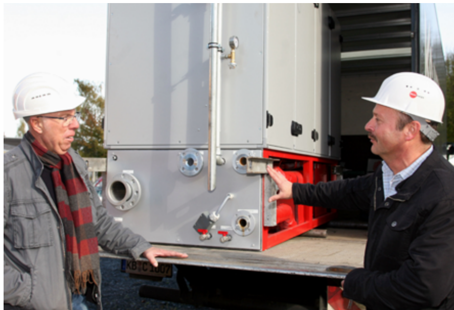
Einbau eines Blockheizkraftwerks (BHKW)
