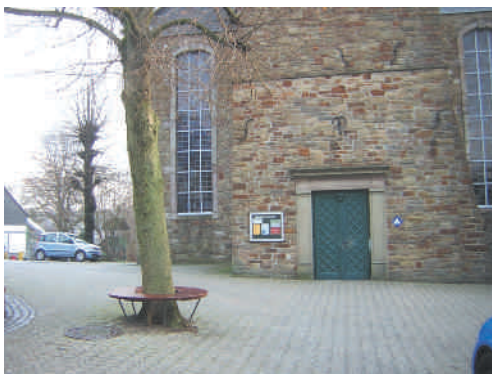
Eingangsbereich der ev. Kirche Dabringhausen
