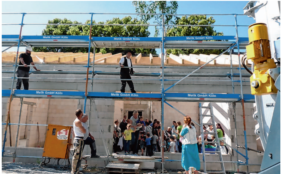
Mit Spannung verfolgen die Kinder den Baufortschritt in ihrer Kita.
