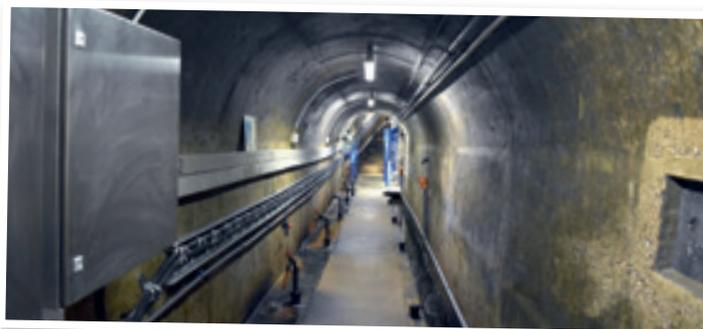
Blick in den Kontrollgang mit den blauen Sickerwasserdrainage-Pumpen an der tiefsten Stelle. Hier fällt immer etwas Sickerwasser an, das kontinuierlich gemessen und nach außen abgepumpt wird. Sollte es einen verstärkten Anfall von Sickerwasser geben, weiß man, dass irgendwo im Untergrund etwas nicht stimmt, und kann eingreifen. Viele weitere technische Details erfahren Sie bei den Führungen durch die Staumauer am 22.09.2018. (© Wasserverband Eifel-Rur, M. Seiler)
