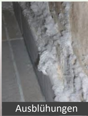
Defekte Außenabdichtung
